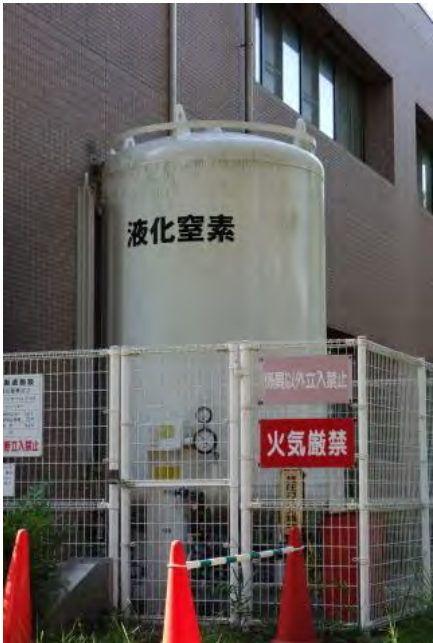
図1 コールドエバポレーター
