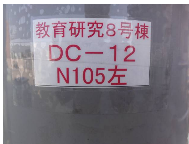
3) 屋上送風機 ラベル貼付
