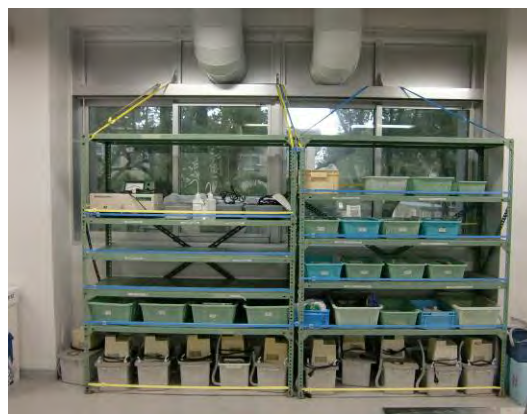
写真2 棚からの荷物の落下防止対策
