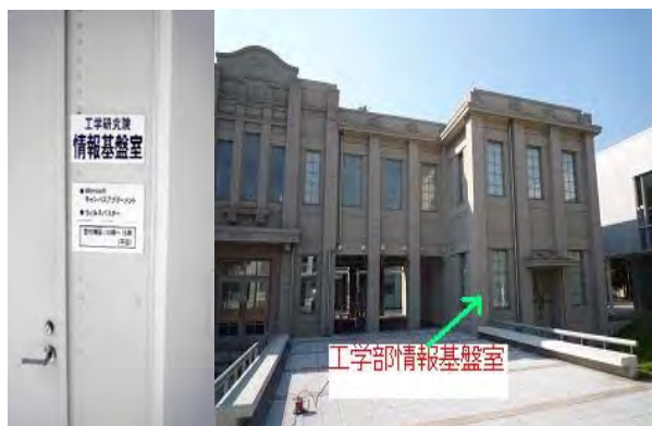
工学部情報基盤室建物
