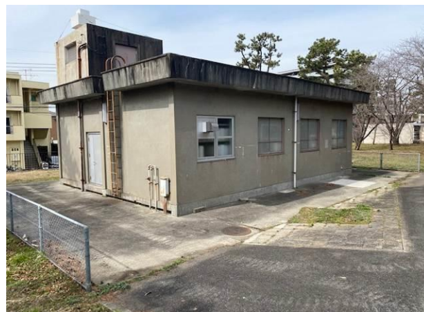
図2 (新)空タンク保管庫
